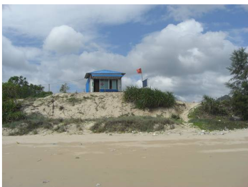
(1): Bãi biển khu vực Trạm Cứu hộ chưa bị xói, chưa có dòng rip (28/11/2011)
